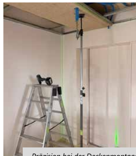
...Präzision bei der Deckenmontage
