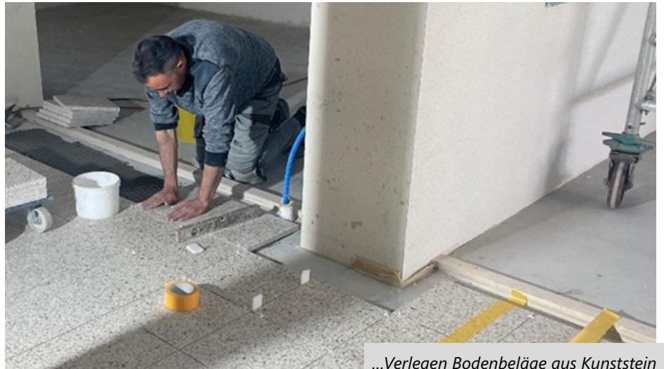
...Verlegen Bodenbeläge aus Kunststein
