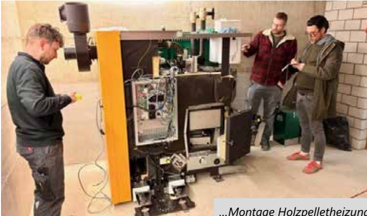
...Montage Holzpellettheizung
