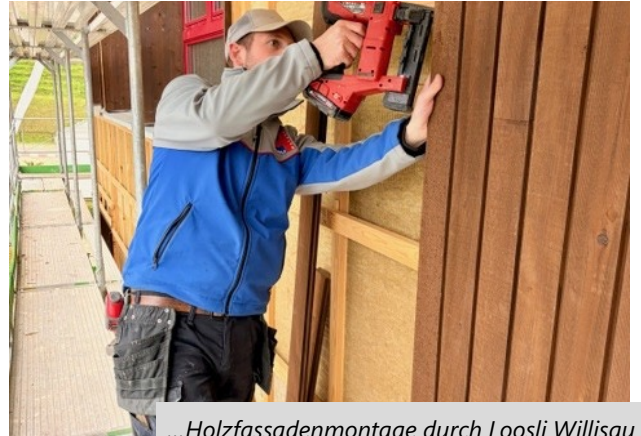
...Holzfassadenmontage durch Loosli Willisau
