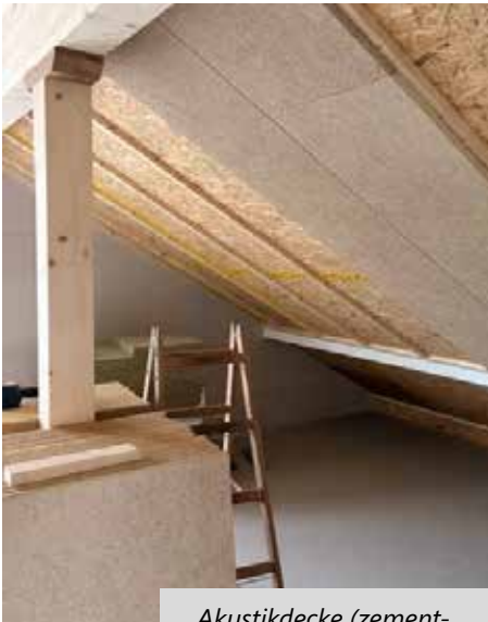
...Akustikdecke (zementgebundene Holzwolleplatte)
