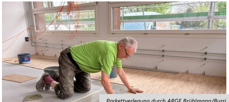
...Parkettverlegung durch ARGE Brühlmann/Burri
