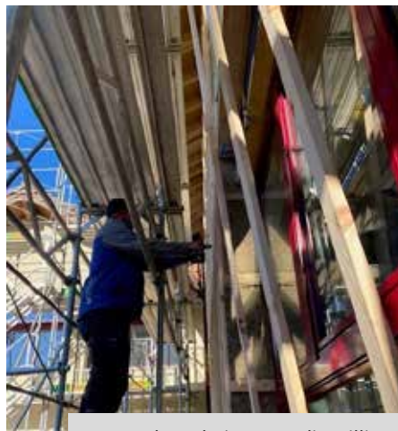
...Fassadenarbeiten Loosli, Willisau
