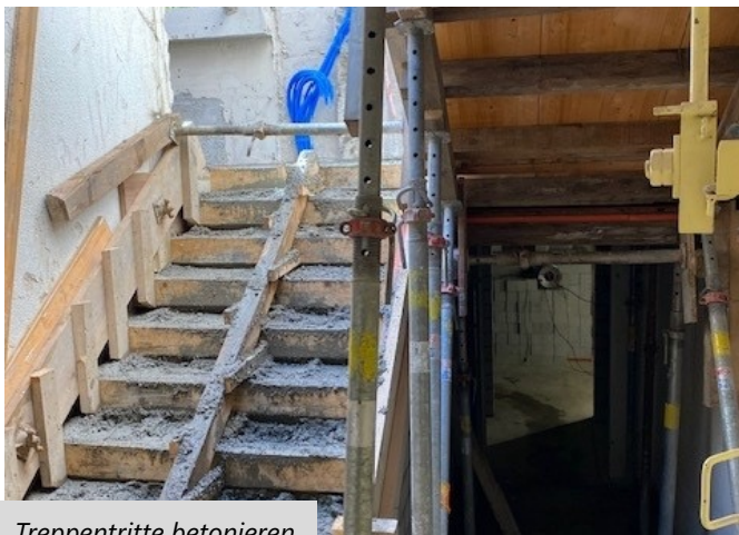
...Treppentritte betonieren
