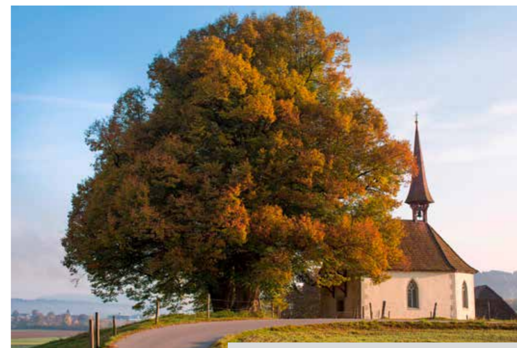
Die Kapelle Schloss Wyher muss dringend saniert werden
