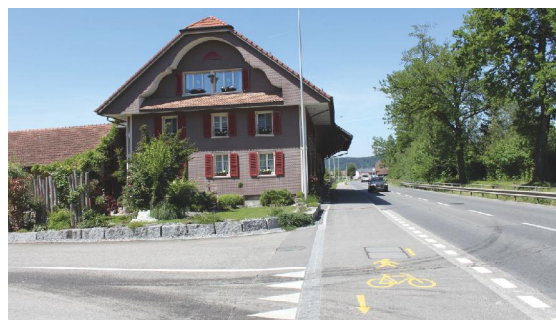
Abb. 23: Hauptstrasse Willisau-Schötz mit Radweg
